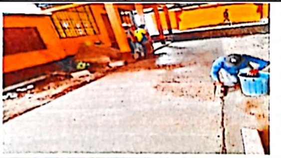
Foto 4: DURANTE LA EJECUCION DE LA OBRA
