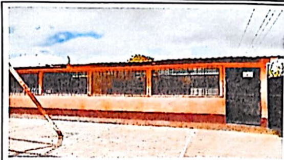
Foto 2: antes del cambio de techo
