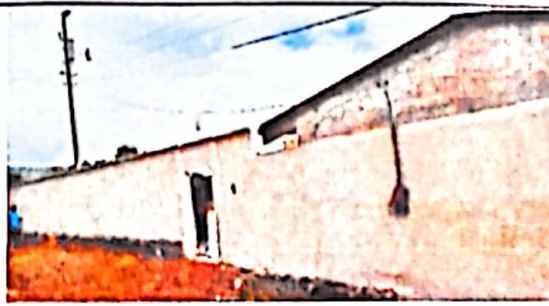
Foto 5: MURO Y REPELLO CONCLUIDO
