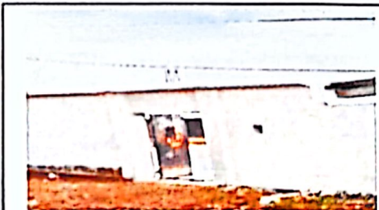
Foto 6: MURO Y REPELLO CONCLUIDO
