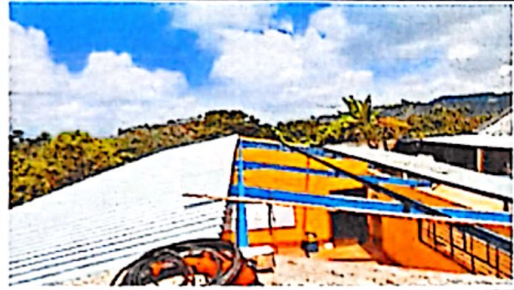
Foto 2: DURANTE EL CAMBIO DE TECHO
